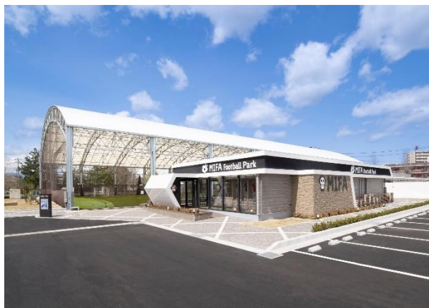
工事事業施工事例（MIFA仙台）
