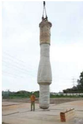
【HND-NB工法により施工した杭】
