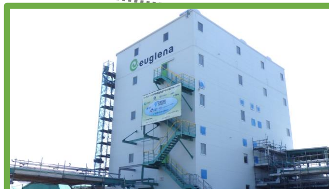
建設現場の様子
