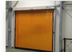
物流倉庫等のシートシャッター
