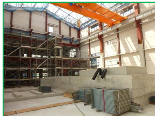
タービン棟内部の状況
