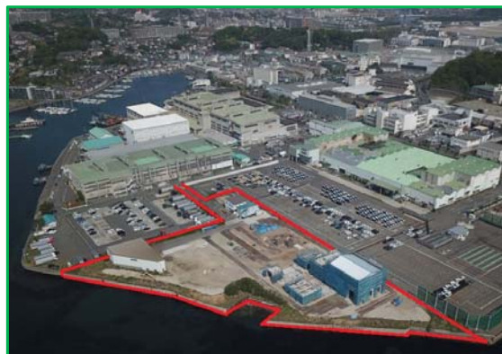
建設中の横須賀バイオマスエナジー
