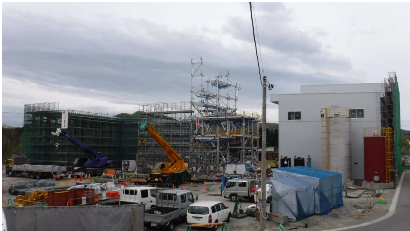
来年春稼働を目指し急ピッチで工事が進行する秋田グリーン電力㈱
