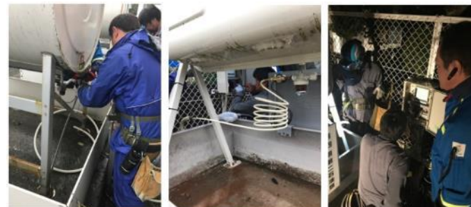
協業による灯油タンク残量監視ソリューションの施工模様
