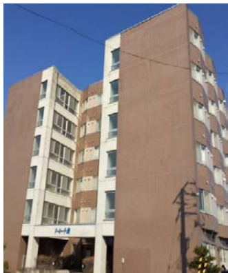
スカイヒルズ栄町 (北海道千歳市 2002年竣工) 工事費 85百万円
