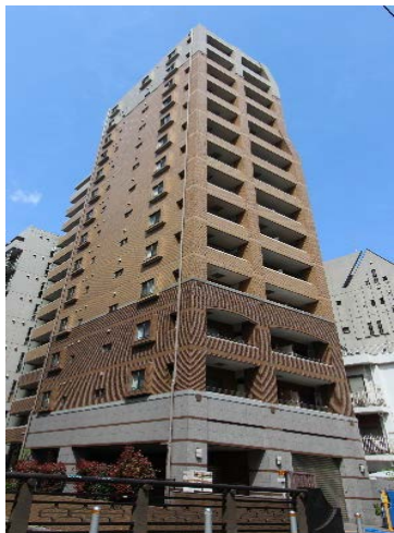
プロスペクト・グラサ広尾 (東京都渋谷区 2005年竣工) 工事費 107百万円
