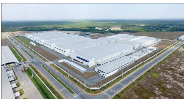
第1工場第2期建設工事 完了
