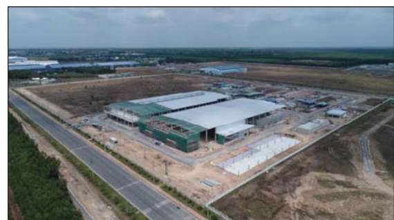
第2工場第1期建設工事
