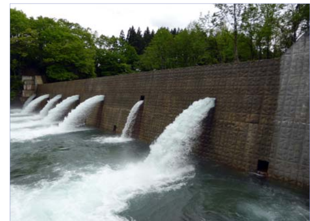
デコメッシュ使用による砂防堰堤
