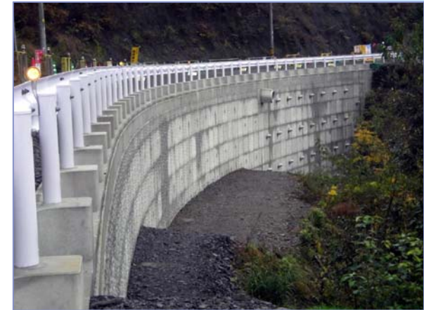
PCW工法による道路拡幅
