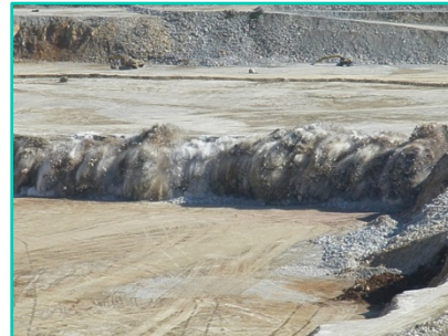
東谷鉦山石灰石採掘工事 （爆砕工事）
