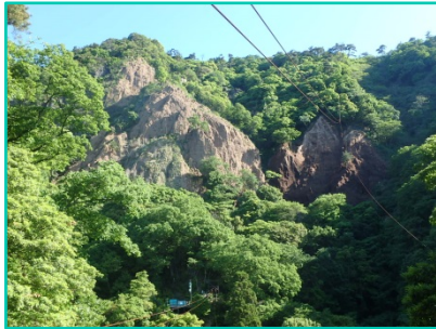
芋川谷山腹工事 （法面保護工事）
