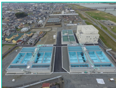
加納浄水場凝集沈殿池築造工事
