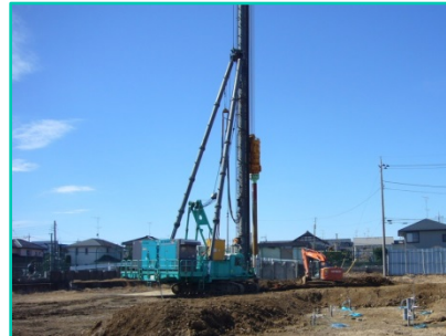
東松山土壌改良工事 （地盤改良工事）
