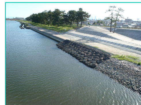
庄内川下之一色しゅんせつ工事
