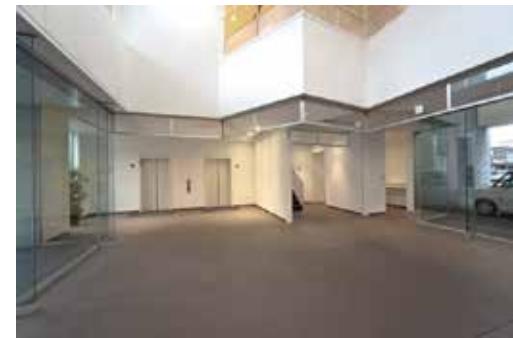
不燃シート製の防煙垂れ壁 「ケムストップ」施工事例
