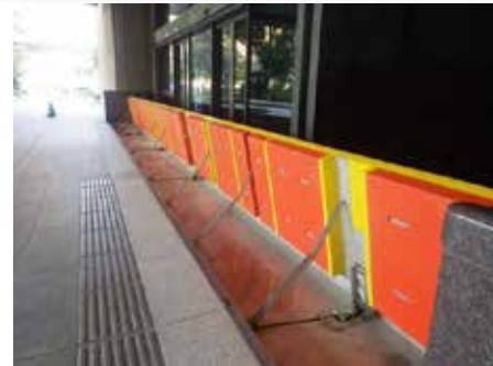
広島市役所に施工した止水製品 「浮力起伏式止水板」
