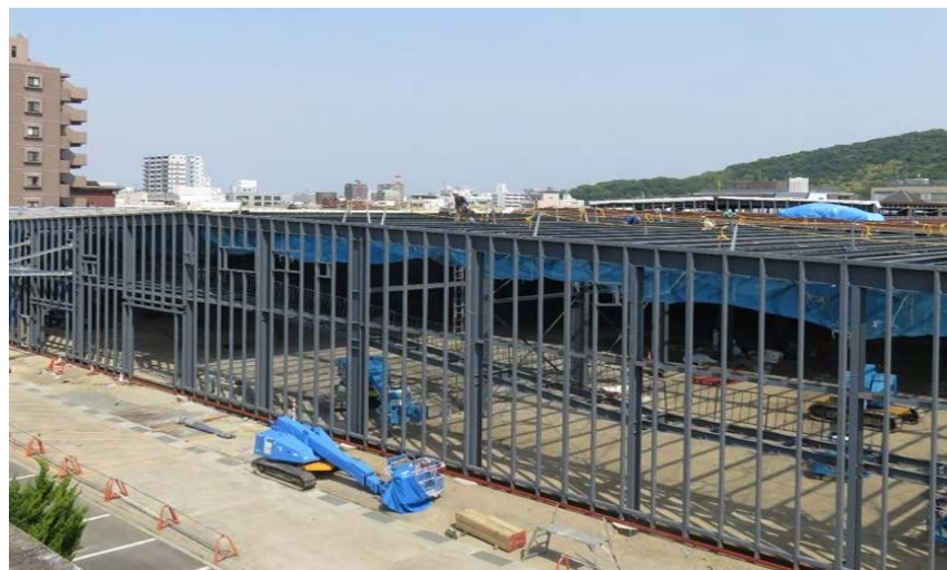
建屋建設は順調に進行中
