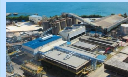
排熱発電設備
