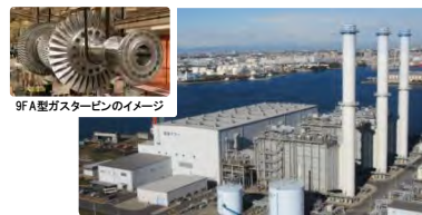
扇島パワーAGP化 改造工事受注 (2018年2月)
