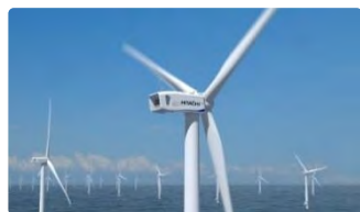
台湾電力・彰化風力 風力発電機21基受注 (2018年2月)
