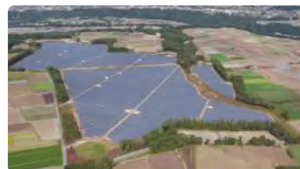
いちご昭和村生越 ECO発電所 竣工 (2017年10月)
