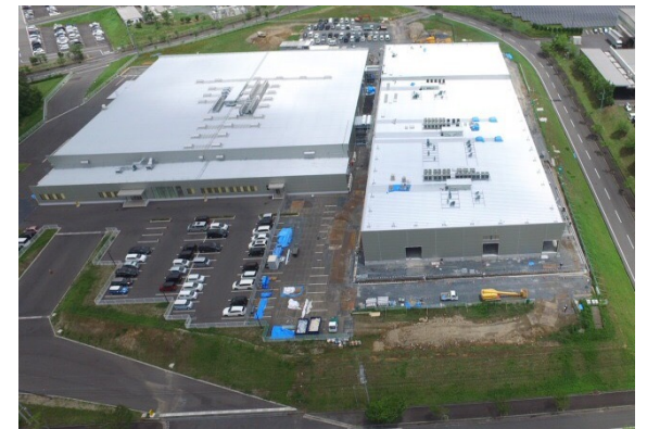
〔増設棟（右側） 工事中の岡山事業所〕
