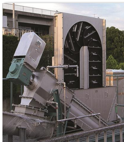
マルチメッシュスクリーン (ろ面循環型微細目スクリーン)
