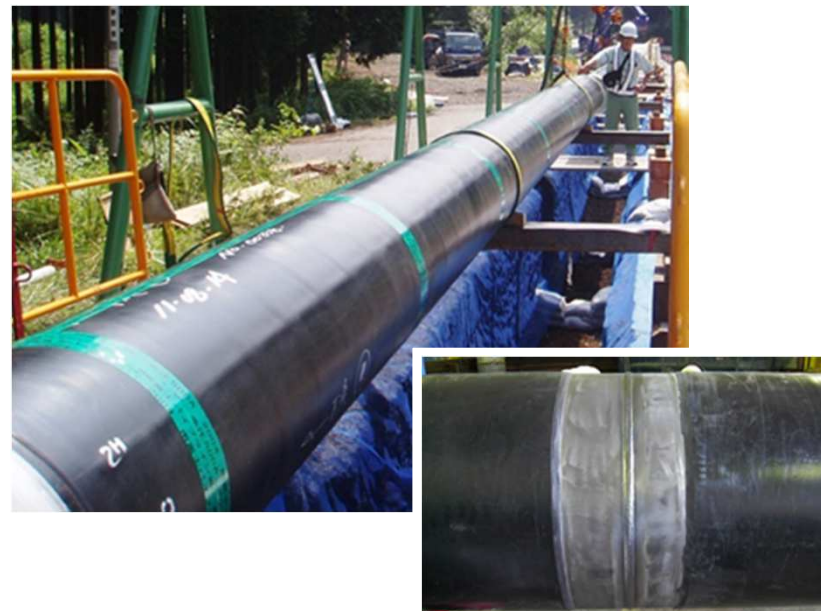
地震の揺れや液状化にも強い溶接鋼管を使用
