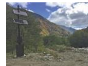
土砂災害の緊急監視 (土砂移動監視)
