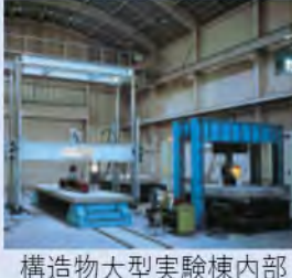
構造物大型実験棟内部
