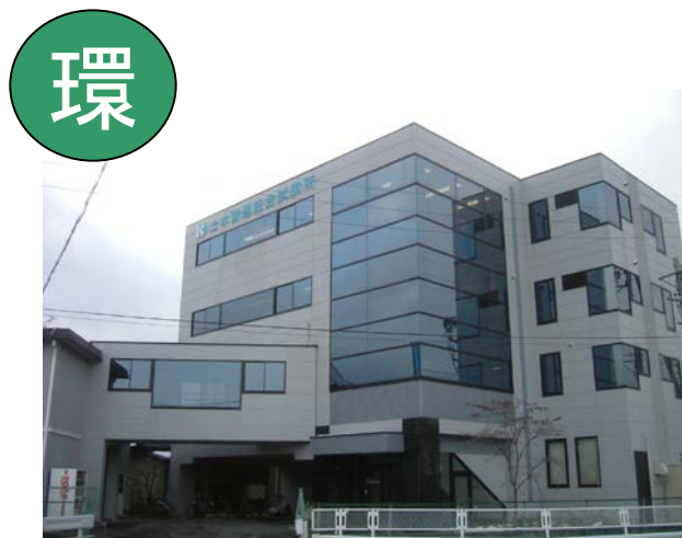
環境分析センター(長野県長野市)
