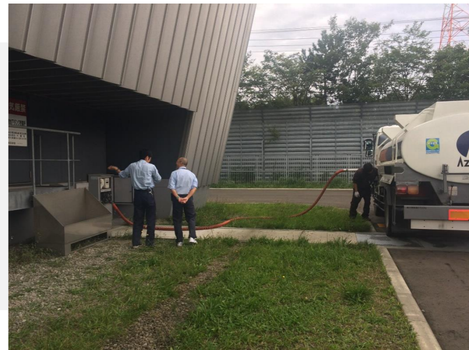
▲非常用発電設備の追加燃料給油の様子
