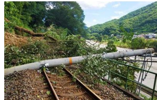
伯備線（備中高梁～木野山駅間） コンクリート柱折損・土砂流入
