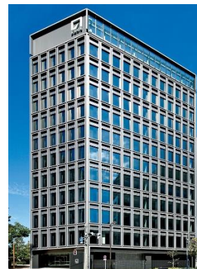
「S-GATE 日本橋本町」 2018年10月竣工
