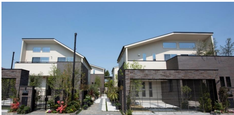
外観・外構写真
