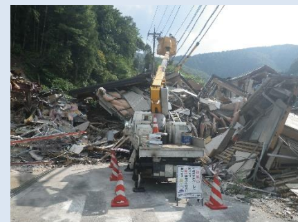
西日本豪雨災害復旧 (岡山県)
