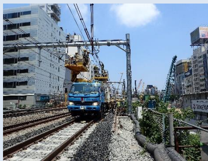
渋谷駅電車線路改良 (東京都)
