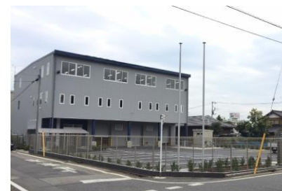
完成した大宮支社
