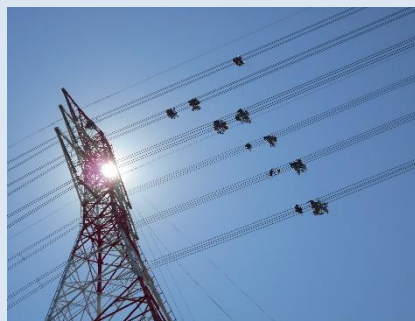
香取線No.26~35鉄塔建替 (茨城県)
