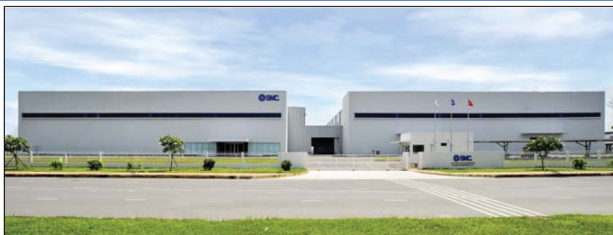
第2工場第1期建設工事 完了
