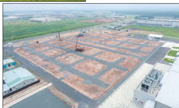
第2工場第2期建設工事
