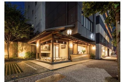
松栄堂薫習館改装工事(京都市)
