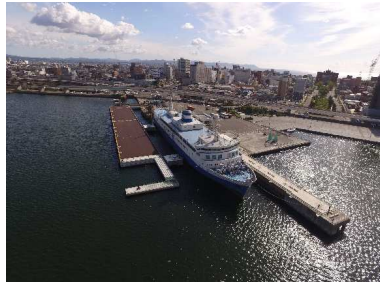
函館港若松地区岸壁ドルフィン部その他工事(北海道)
