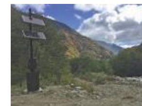
土砂災害の緊急監視 (土砂移動監視)
