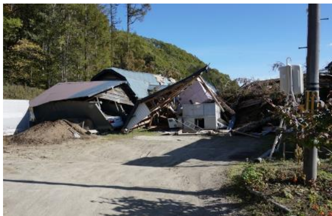
厚真町へ設置時の被災状況
