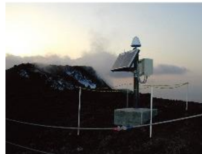
火山活動による 山体膨張・収縮などを監視
