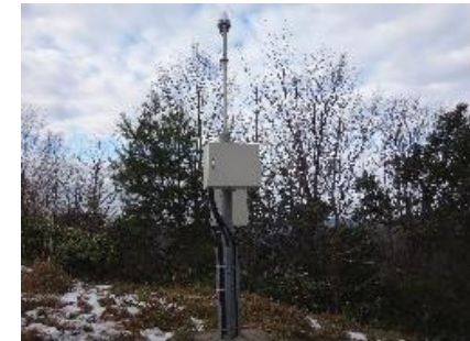
地盤が緩いエリアにおける がけ崩れの予兆監視
