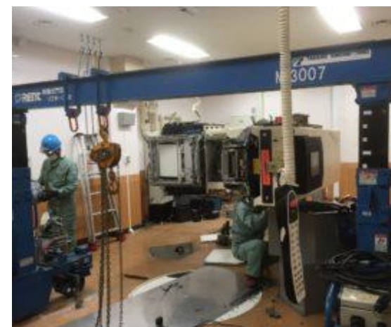
【屋内での解体作業状況】
