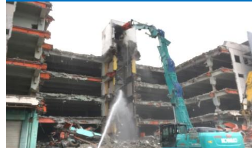
鉄筋コンクリート造解体
