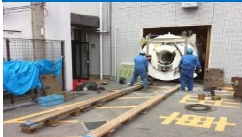
壁面切断・MRI撤去
