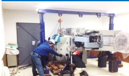
リニアック解体搬出
