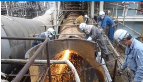
プラント ガス解体
