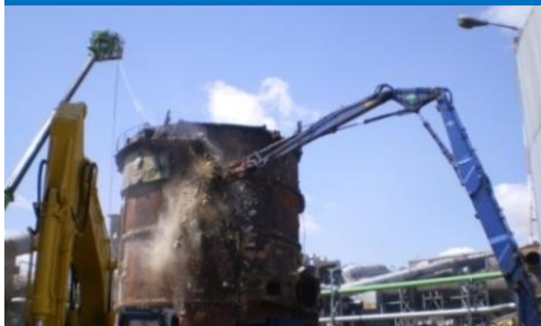
プラント 重機解体
