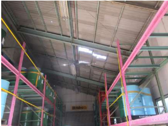
図 26 ⑤危険物倉庫
