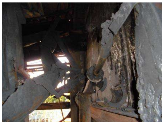
図 77 破断したキシレン溶液の配管
