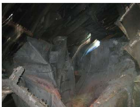
図 101 北固化室下のホッパー上部
