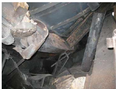
図 100 北固化室状況
