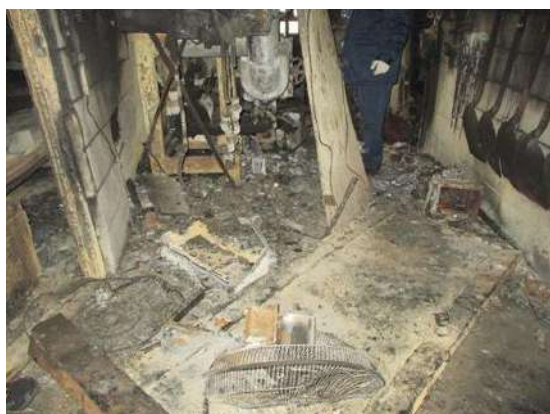
図 94 吹き飛んだ南固化室の扉
