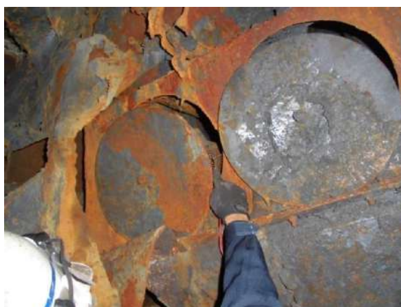
図 51 集じん機と接地極間の抵抗測定の状態
