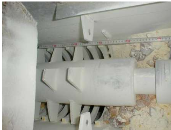
図 43 スクリューコンベア先端の解砕機（北固化室，発災前）
