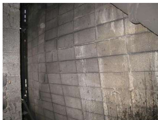
図 93 変形した南固化室の東壁
