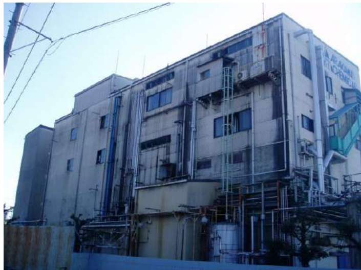
図4 発災以前の当該製造棟（北西方向からの撮影）
