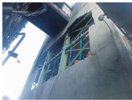
図 25 ④ 自動倉庫
