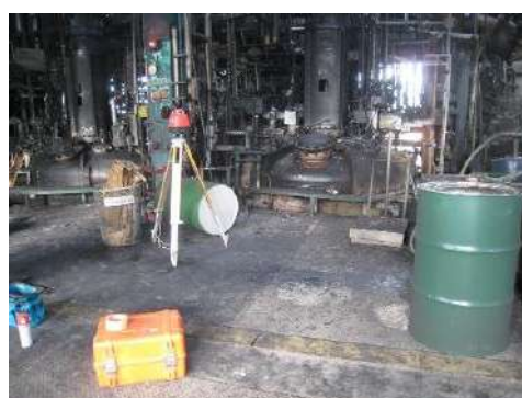
図 107 4階製造釜Cの沈降の監視状況
