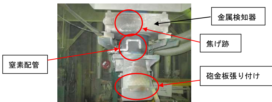
図 65 2016 年 10 月 23 日の発火事例後の回転型スライド弁周辺の様子
