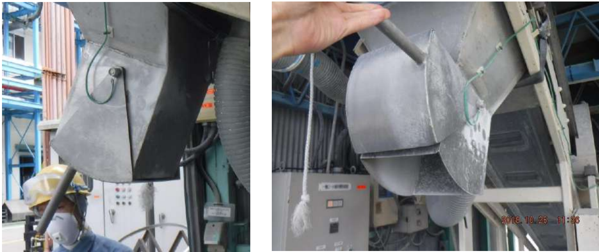
図 46 回転型スライド弁（類似品）
