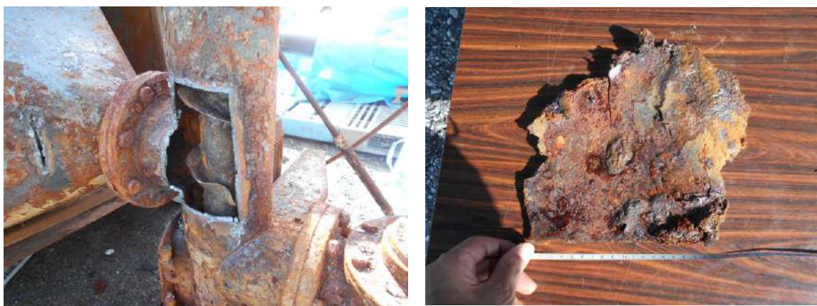
図 72 集じん機左側下部のスクリーフィーダーの羽根の変形と底部を塞いでいた鋼板
