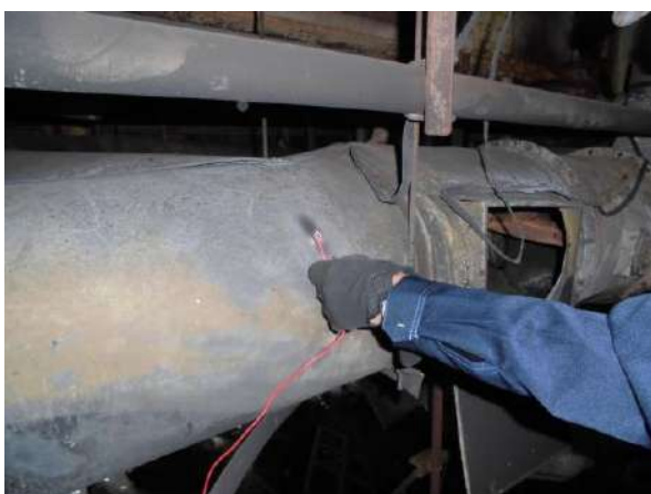
図 50 ダクトと接地極の間の抵抗測定の状態
