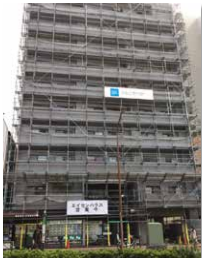
リニューアル工事中のビル
