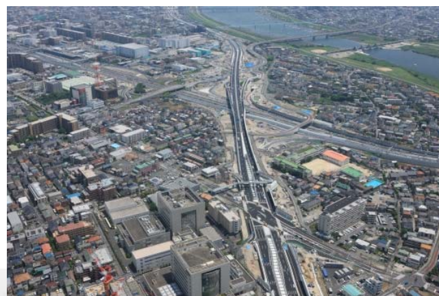
東京外環市川中舗装工事
