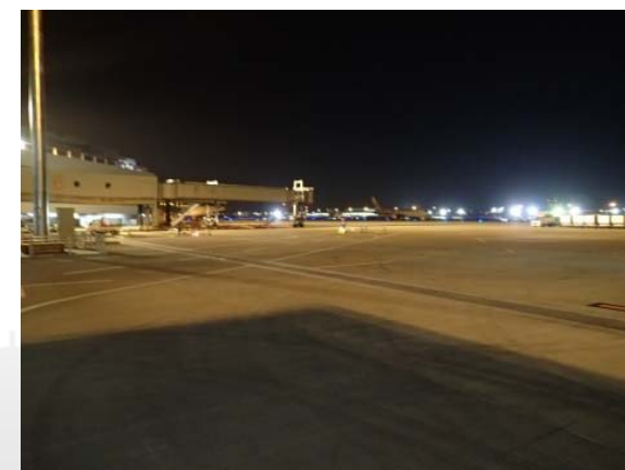
福岡空港エプロン工事
