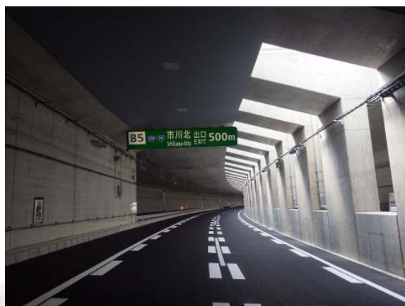
東京外環市川舗装工事
