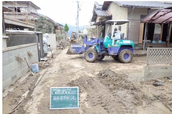
岡山県倉敷市真備町
