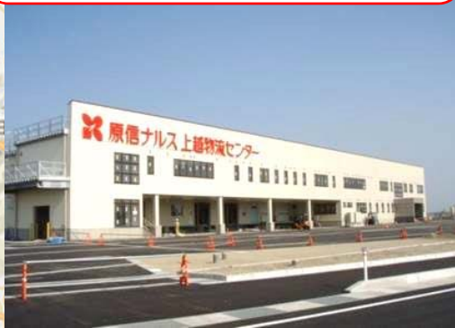
上越チルドセンター 2008年7月設置
