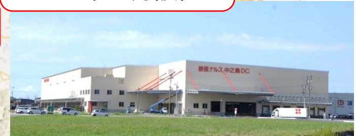
中之島DC 2013年10月設置
