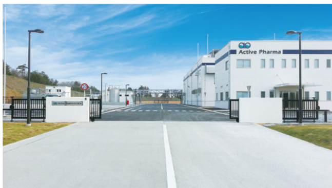
富山八尾工場外観（現状）
