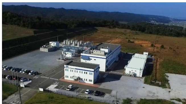
富山八尾工場敷地（現状）
