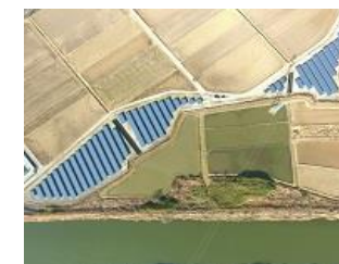
S-18 LS稲敷荒沼2発電所
