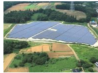
S-12 LSつくば房内発電所
