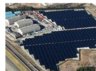
S-10 LS利根布川発電所
