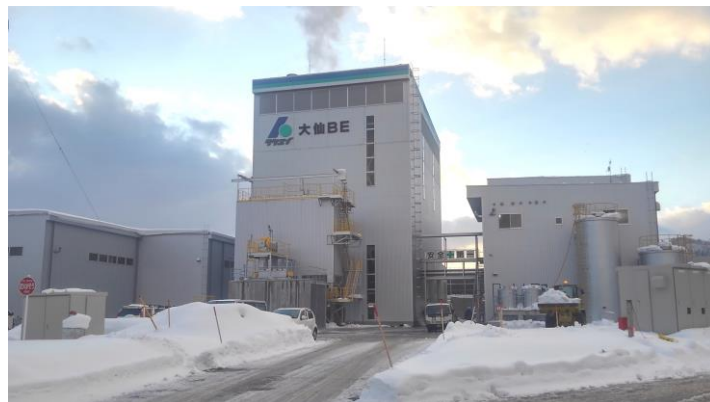
大仙バイオマスエナジー 協和発電所
