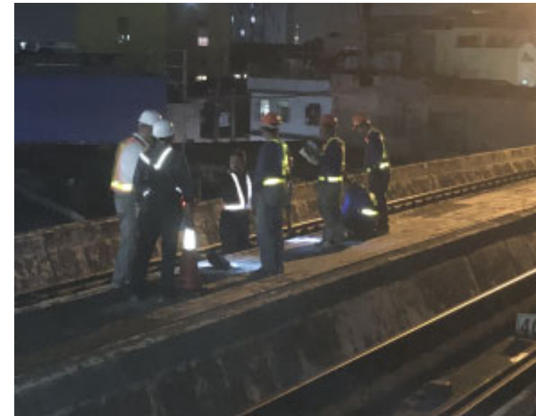
敷設工事の様子
