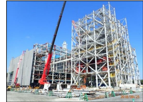
豊前発電所建設状況 (2018/9月)
