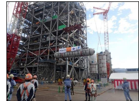
大船渡発電所蒸気ドラム上架式 (2018/10月)
