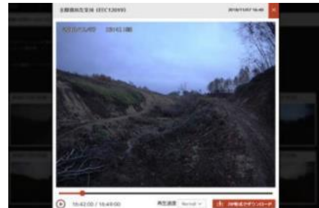
遠隔での監視により二次災害を防止
