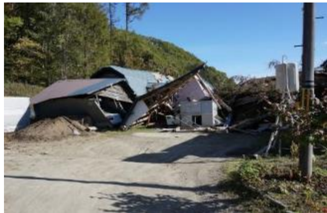
厚真町へ設置時の被災状況
