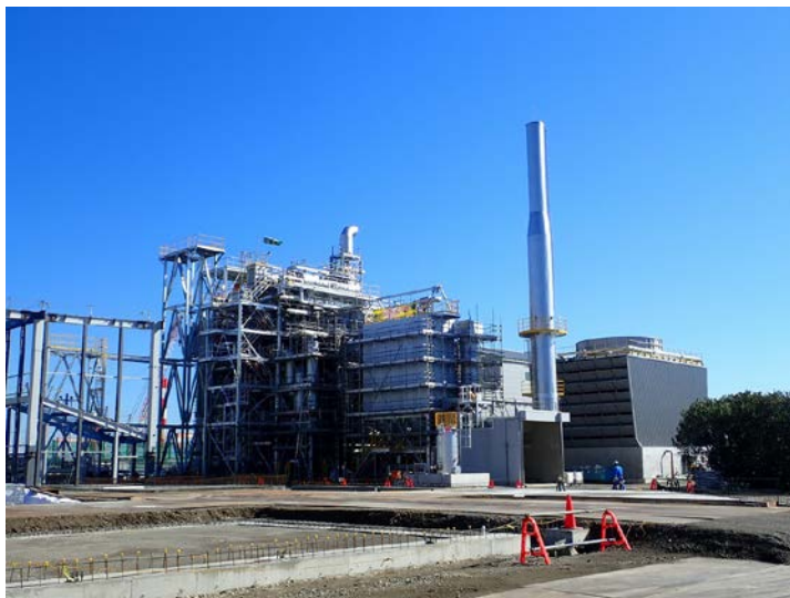
建設工事中の(株)横須賀バイオマスエナジー(2019年3月撮影)
