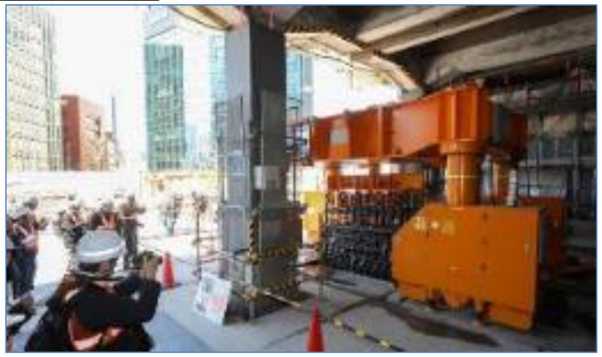
新幹線部 地中連続壁構築
