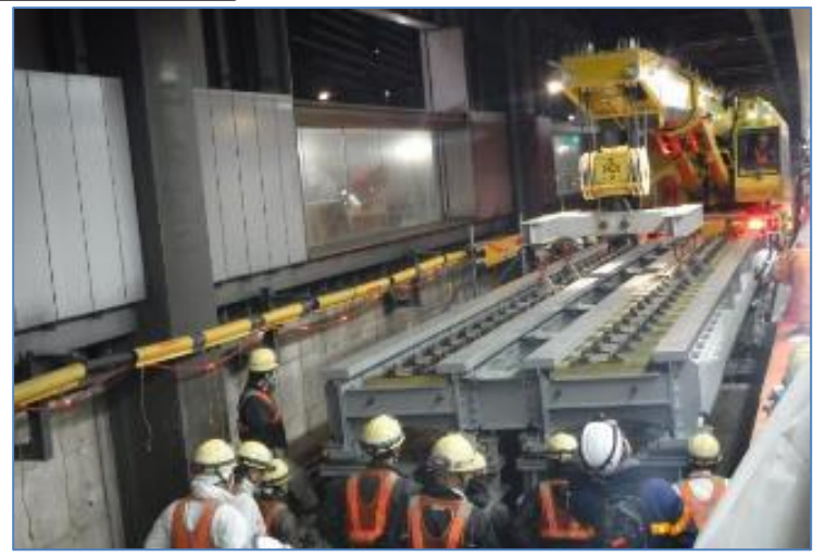
工事桁架設
