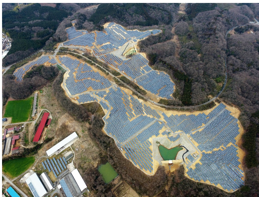
「那須烏山ソーラー発電所」 全景
