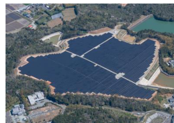
伊勢大仏山 メガソーラー発電所
