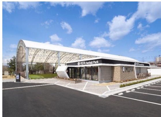
スポーツ施設施工事例 （MIFA Football Park 仙台）
