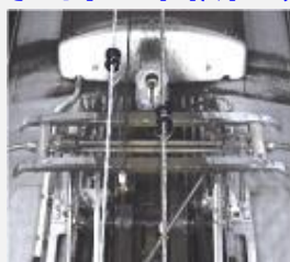
撮影した画像 (屋根上)
