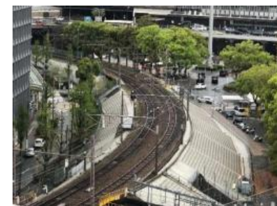
斜面防災対策 (新大阪駅付近)
