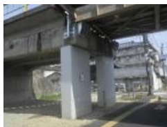
落橋防止対策
