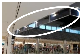
大型ショッピングモールの防煙垂れ壁
