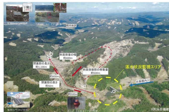
日高幌内川河道閉塞箇所への対応
