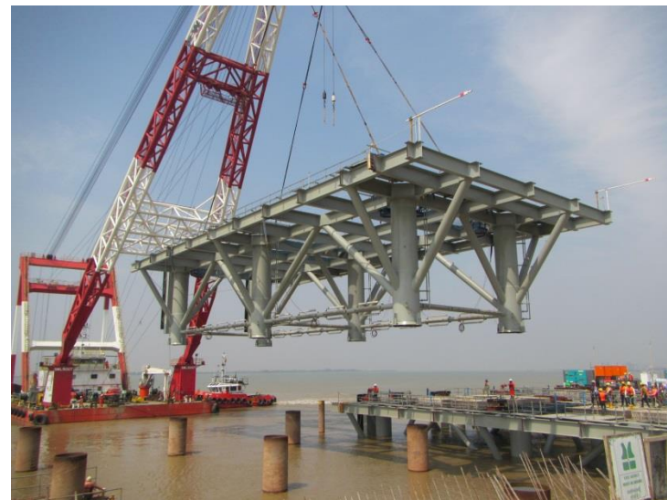
ジャケット(250t)据付
