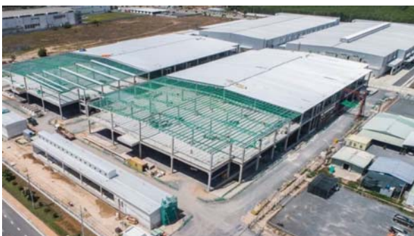
SMC Mfgベトナム 第2工場第2期建設工事
