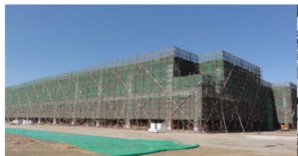
SMC天津製造 第1期工場建設工事
