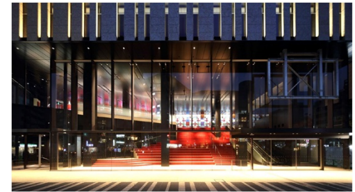
Hareza池袋ホール棟エントランス
