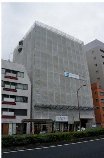
マンションビルのリニューアル工事
