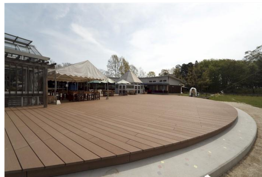
再生複合材「テクモク」の施工例(デッキ)
